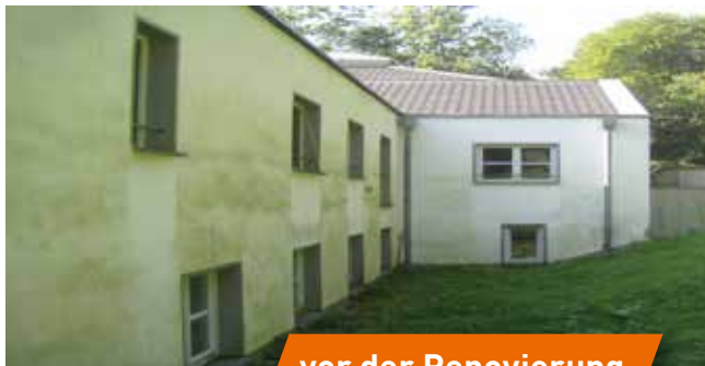
vor der Renovierung
